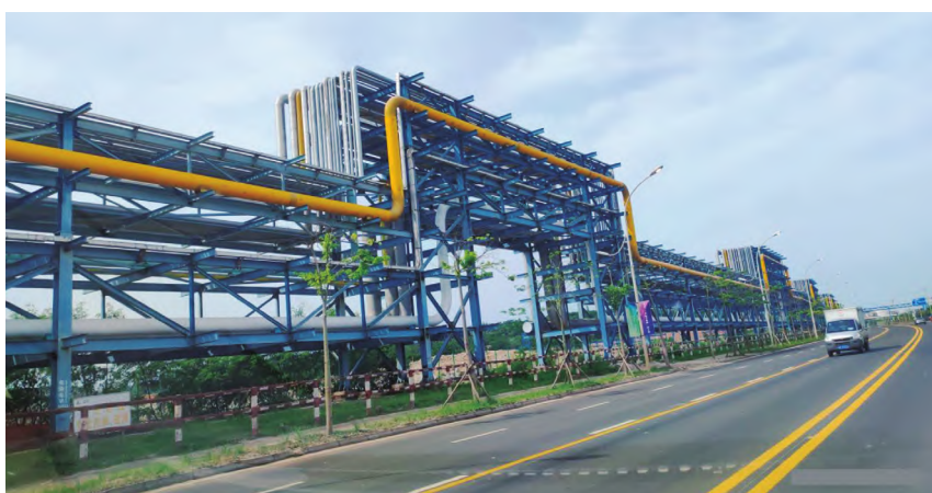
图 2 公共架空管廊及天然气管道
