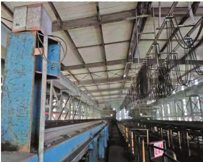
图3 安装使用现场
