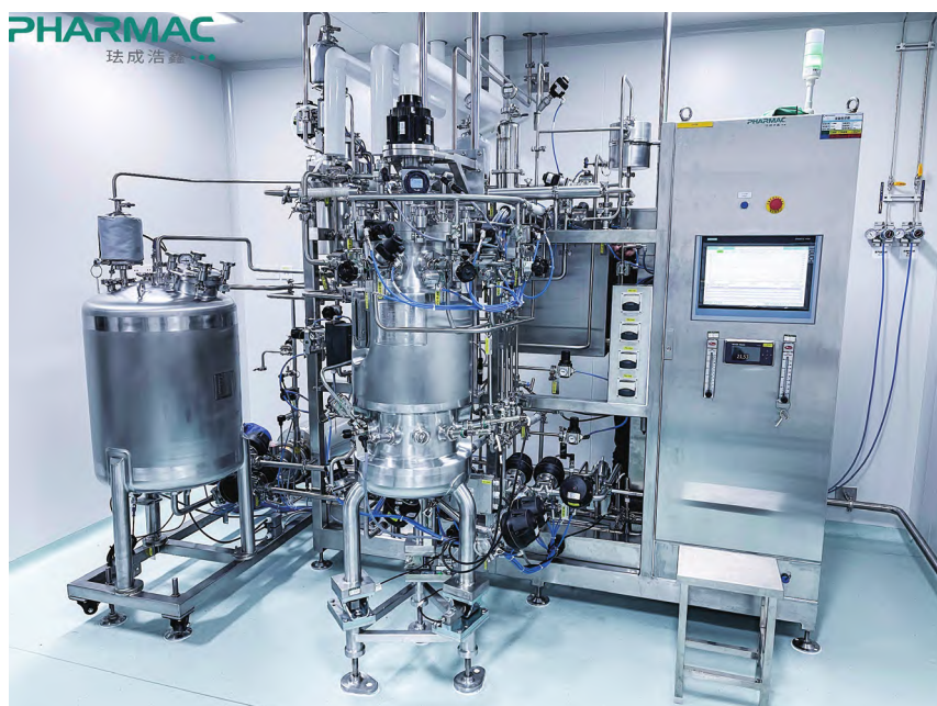
图2 苏州某生物发酵项目 (含 50 L-700 L 发酵系统一套及下游纯化线)
