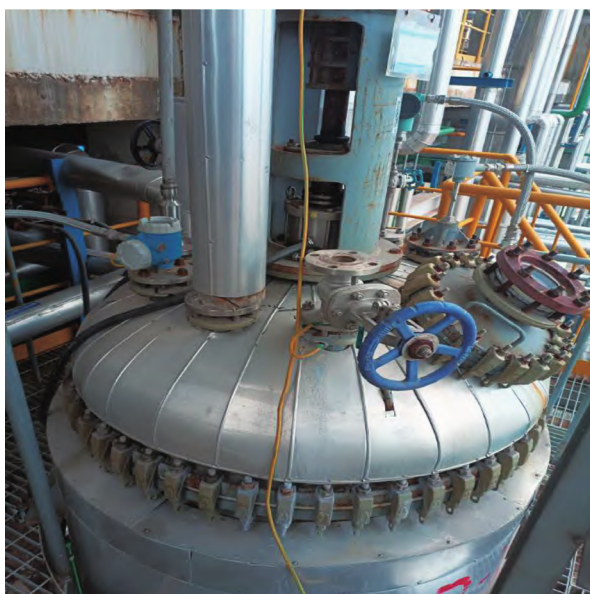
图3 G80 雷达液位计现场安装图
