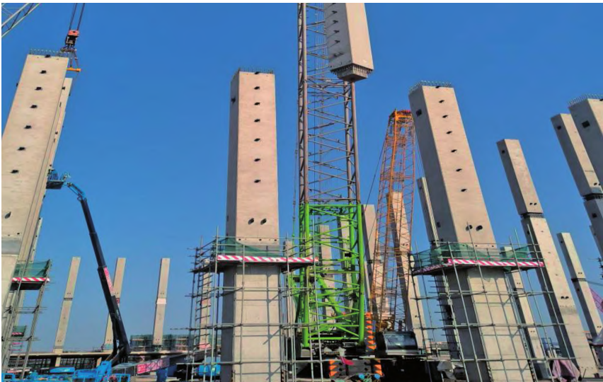
图 3 项目施工现场
