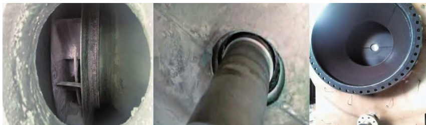
图3 风机蜗壳、叶轮做防腐喷涂前后对比
