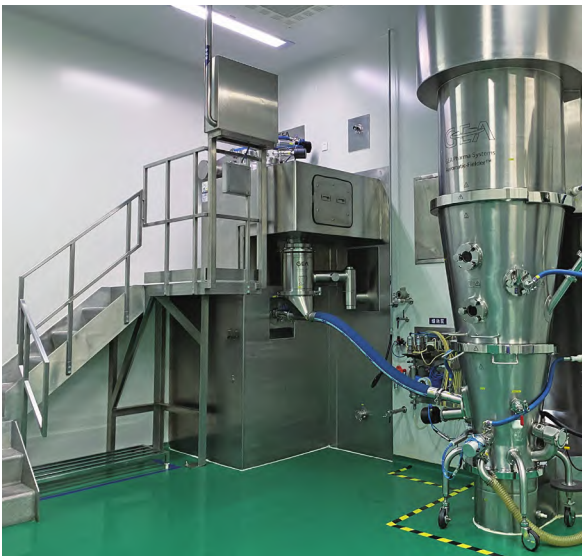
图 1 固体制剂车间制粒间的直排型空调系统
