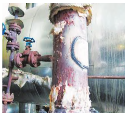
(b) 管道修补后
