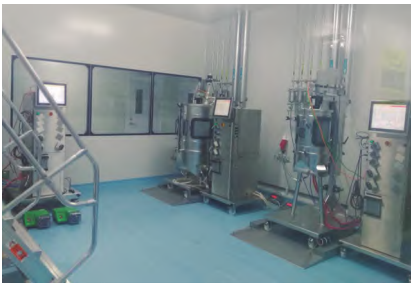
图 8 完工的洁净车间
