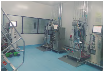
图 8 完工的洁净车间
