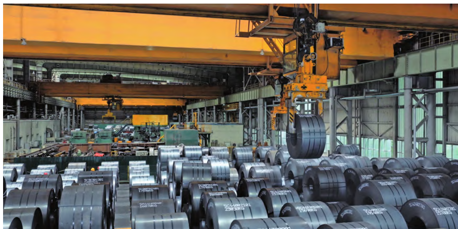
图 1 施耐德电气为鞍钢集团鲅鱼圈分公司提供了行业领先的 IACS 无人行车系统
