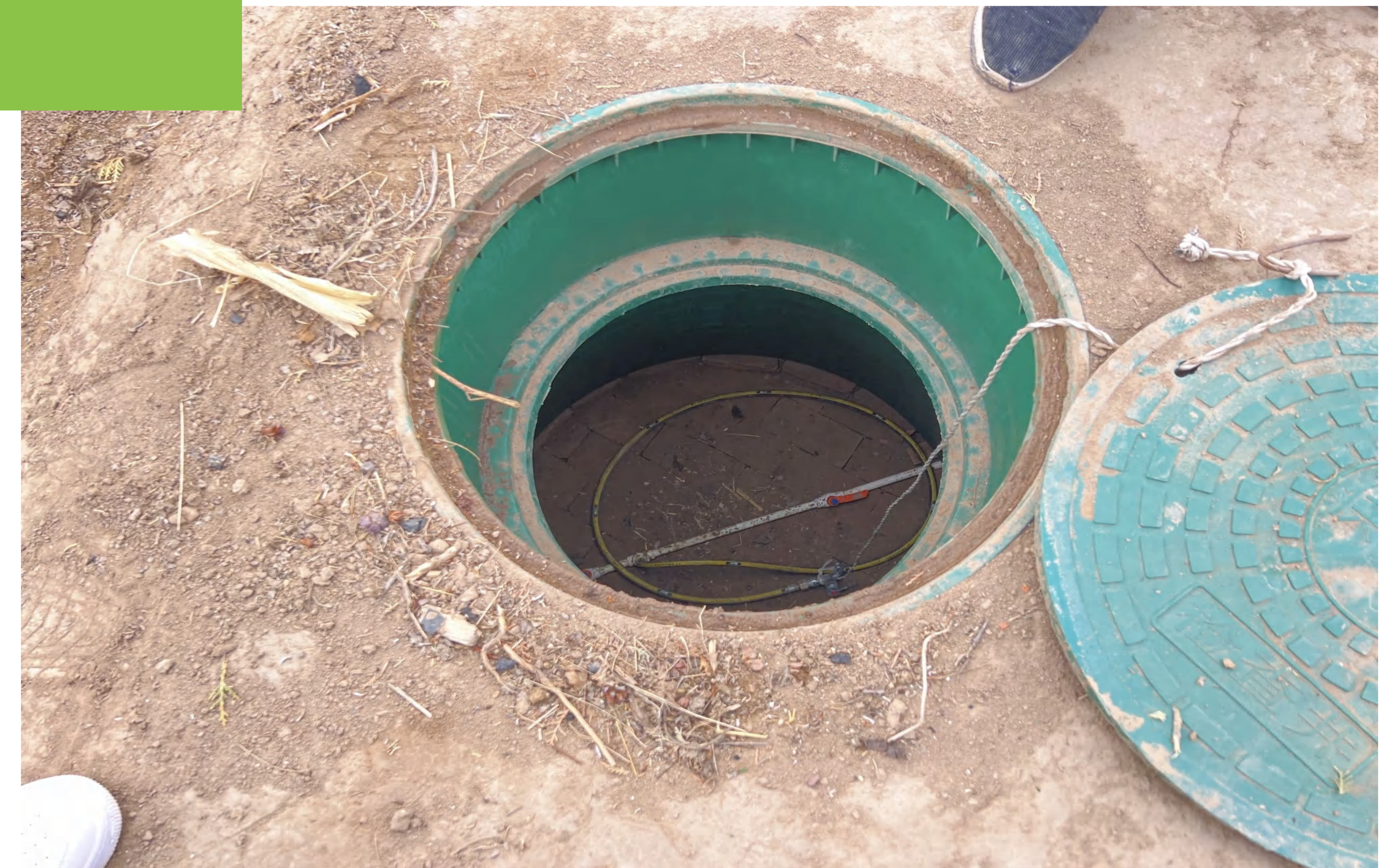
宁夏省固原市高标准农田项目建设—— 农村自来水入户改造施工案例
