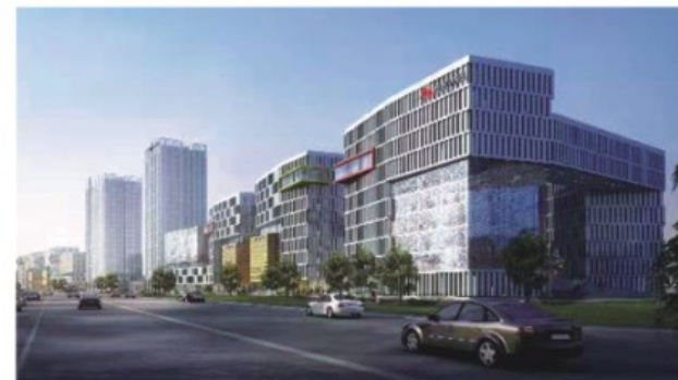
华为桂林数据中心
