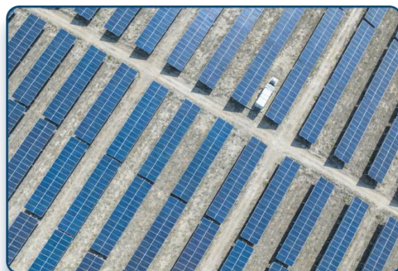
10 莒县宇阳新能源有限公司 25MW光伏发电项目
