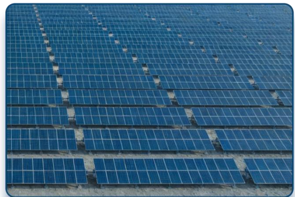
18 临沭县地面电站项目 50MW地面电站项目小EPC
