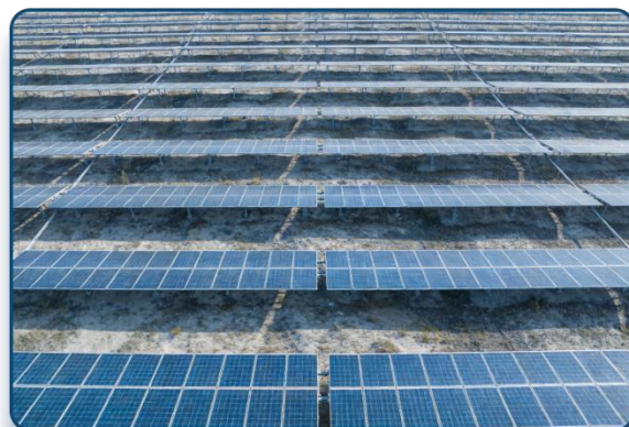
12 华能电力新泰市光伏项目 150MW小EPC项目
