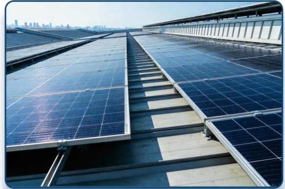
14 泰福智控龙华星越大厦 0.528MW屋顶光伏发电安装
