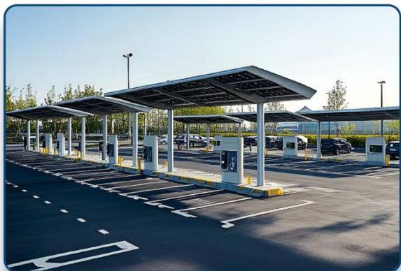
07 东营 泰安 德州服务区车棚 1.7MW光伏发电
