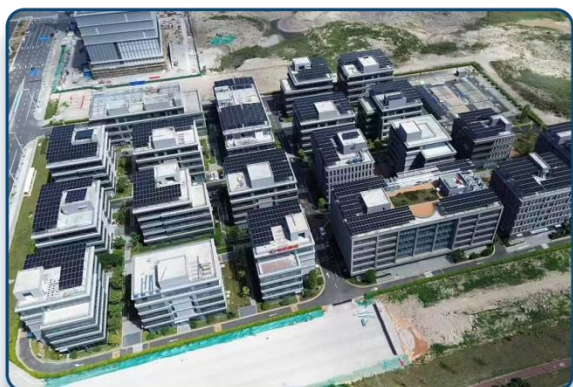
03 深汕合作区数字产业园 2MW分布式光伏发电安装
