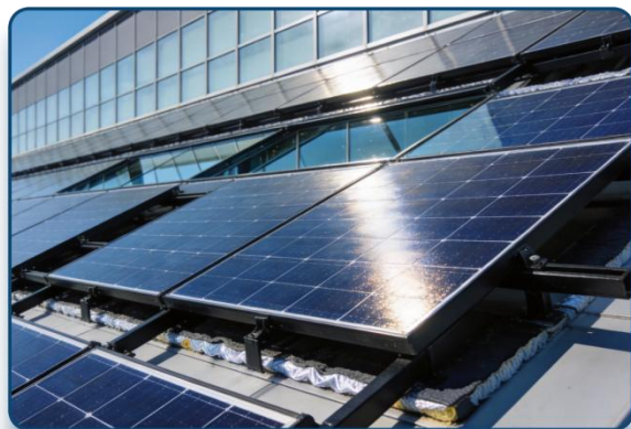
20 广州广园花园 260KW屋顶光伏发电安装
