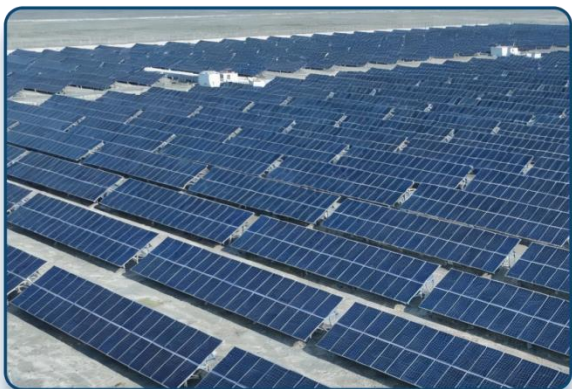
19 费县地面电站项目 50MW地面电站项目小EPC
