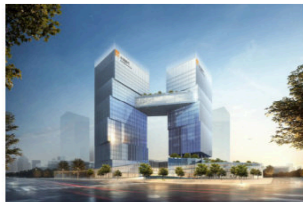
华润燃气总部基地
