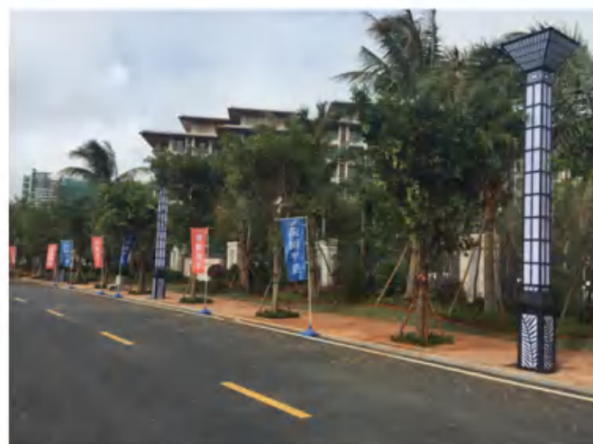
海南清澜半岛景观路灯项目
