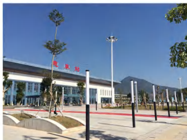
厦深高铁惠东站广场道路亮化照明
