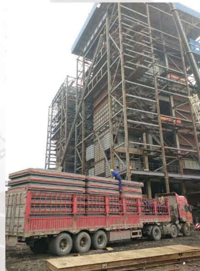
非金属补偿器 / 隔热管托到货现场
