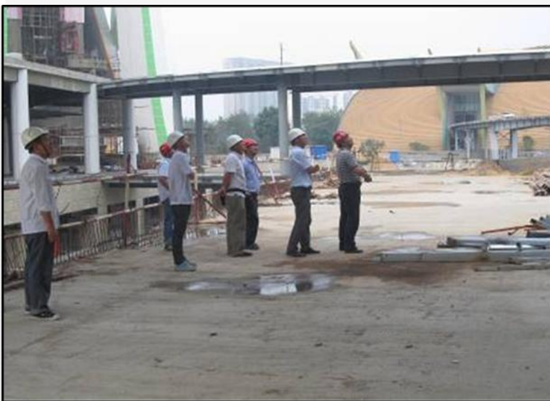
项目安全检查
