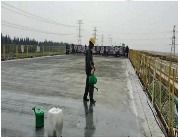
(a) 外涂组喷涂 DPS 永凝液
