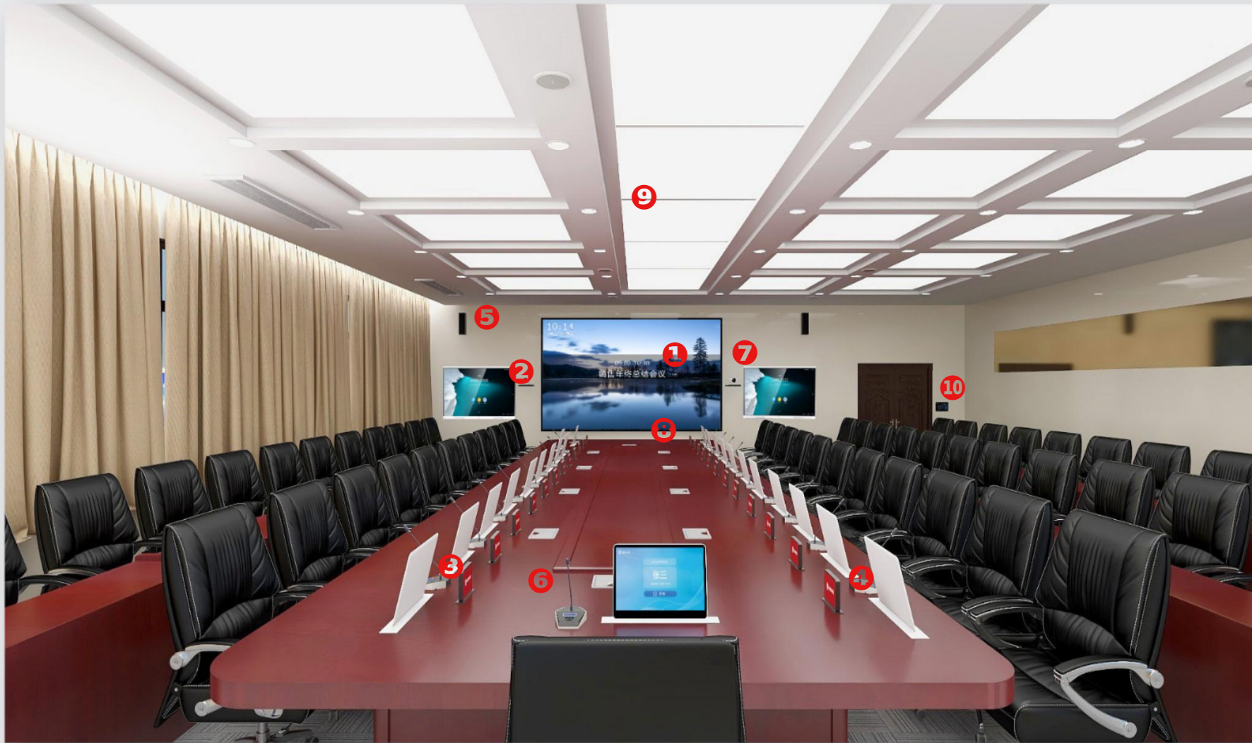
大型会议室建设
