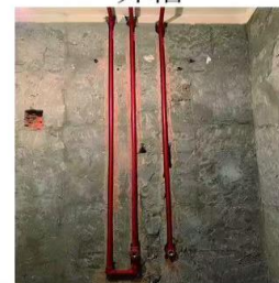
水管安装固定
