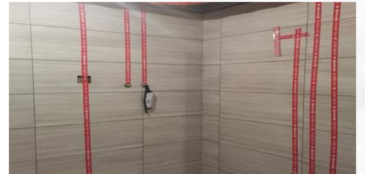
粘贴管路标识，防止打孔破坏
