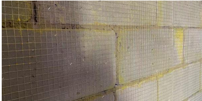
新建墙体挂钢丝网，防收缩开裂
