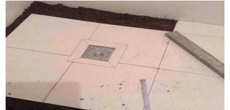
地漏安装，排水坡度
