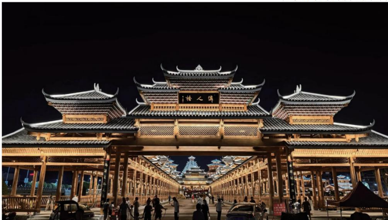
建筑外墙-洗墙灯&投光灯
