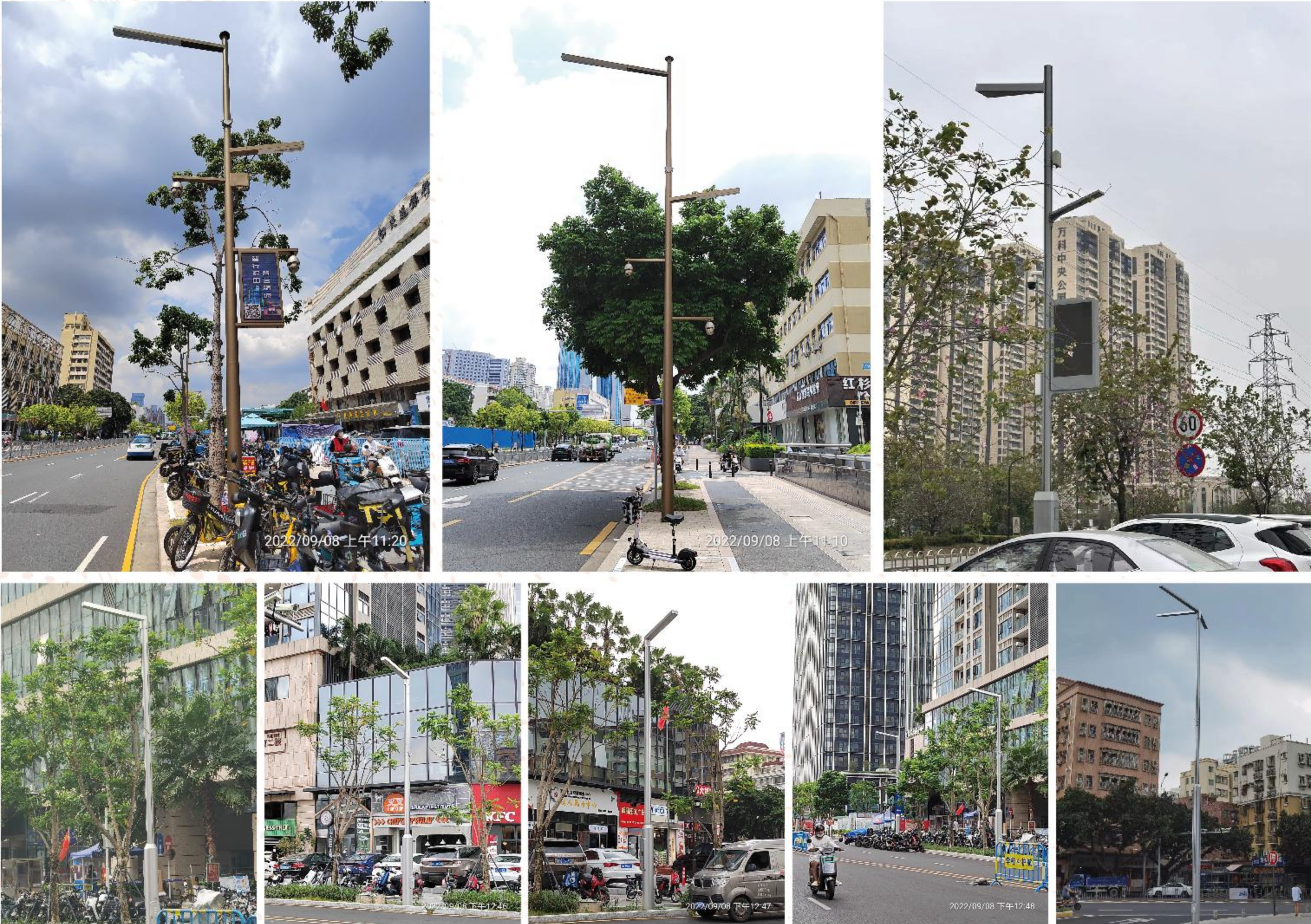
广东省深圳市智慧照明项目
