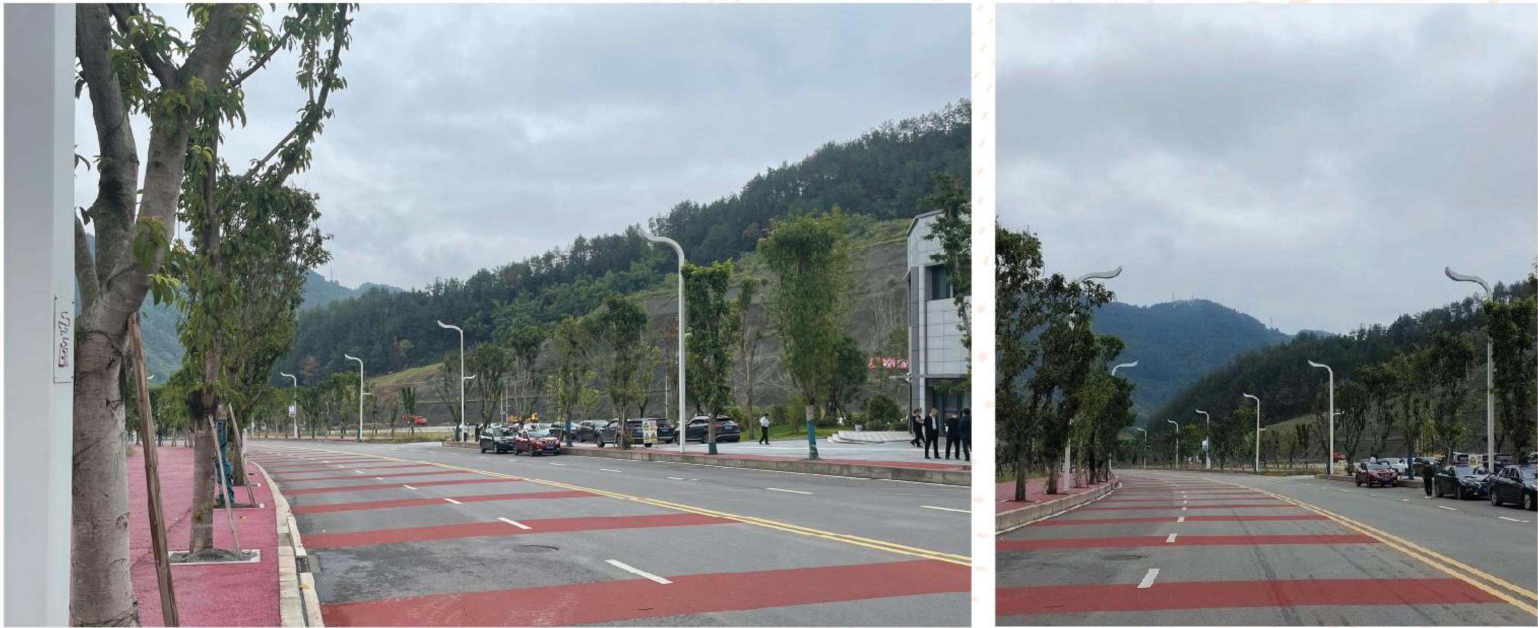
重庆市水口镇道路照明项目
