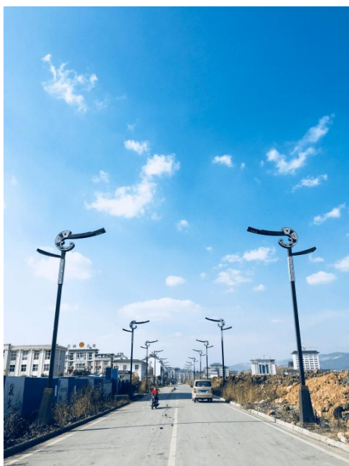
云南省保山市施甸县道路照明工程
