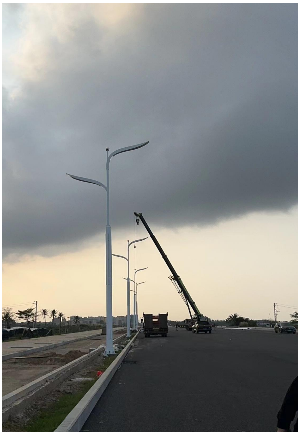
海南海口桂林洋公园大道路灯项目
