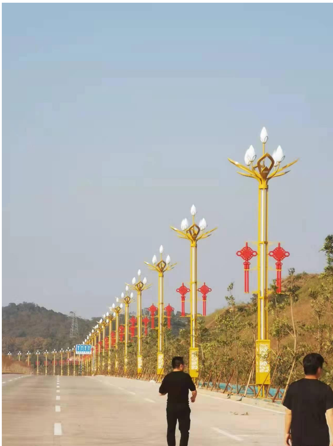
茂名高州永青大道路灯项目
