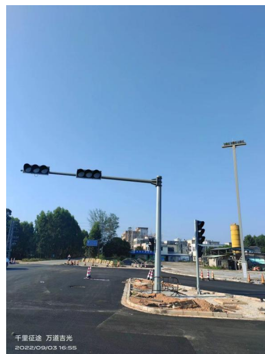
广东雷州经济开发区市政道路
