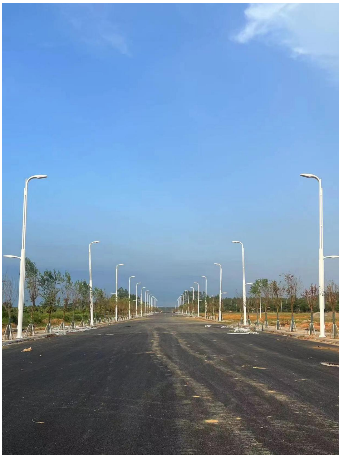
湛江雷州奋勇高铁连接线路灯项目
