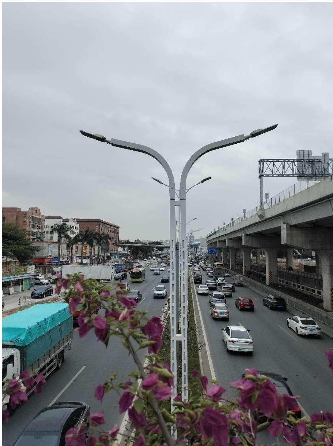
珠海 G105 国道照明路灯项目
