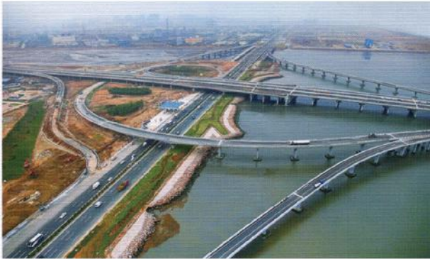
中铁四局胶州湾大桥
