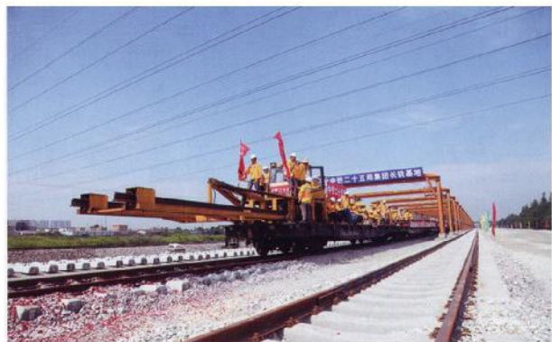
贵广铁路枢纽
