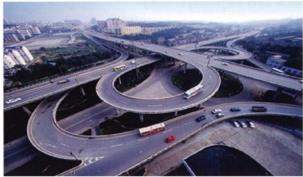
长沙芙蓉路立交桥
