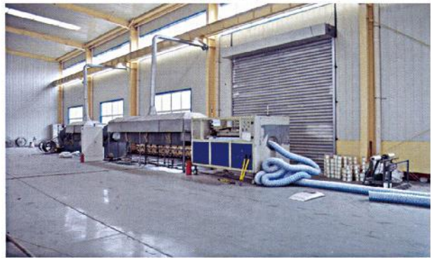
透水管生产线
