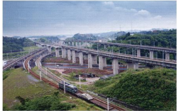
中铁四局宜万铁路
