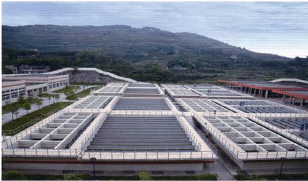
重庆丰收坝净水厂
