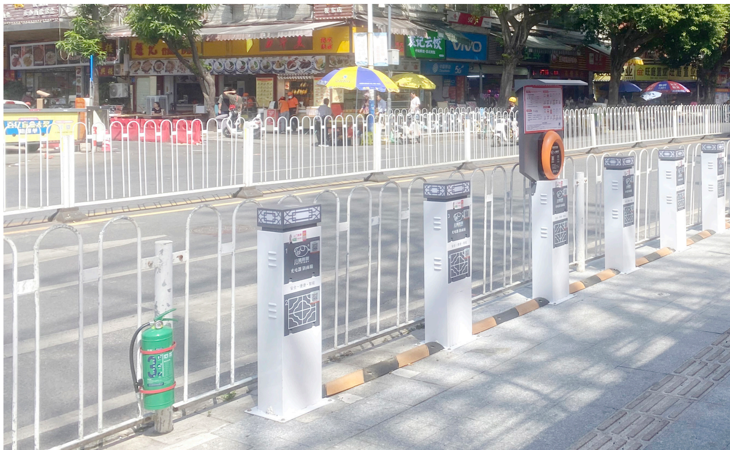
▲ 广州市·荔湾区龙津街道
