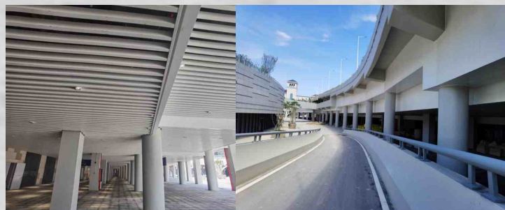
平潭高铁站(福建省优质工程)
