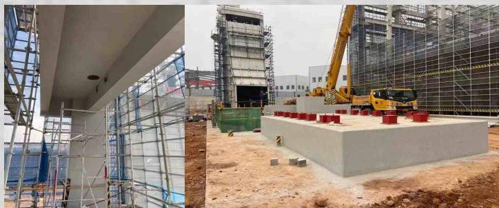
京能宜昌市夷陵区中基天然气热电联产项目
