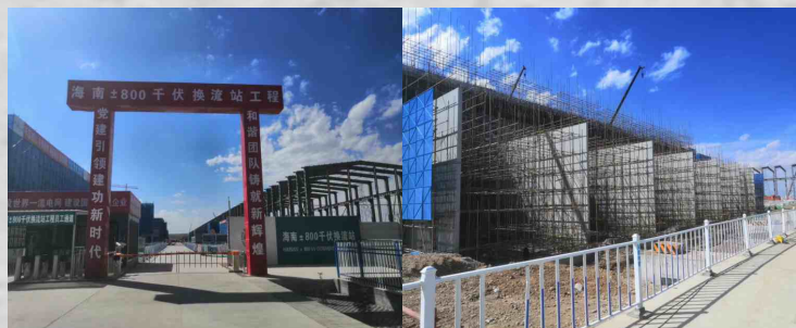
海南±800千伏换流站工程
