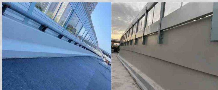
福建福州工业路混凝土处理
