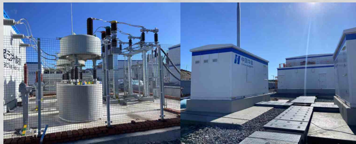
内蒙华能风电升压站基础
