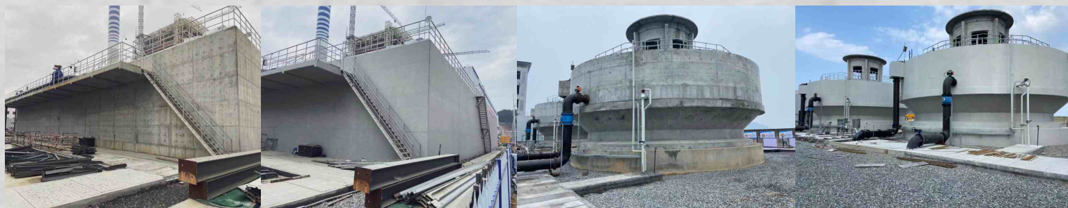
大唐国际新余二期2×1000MW
