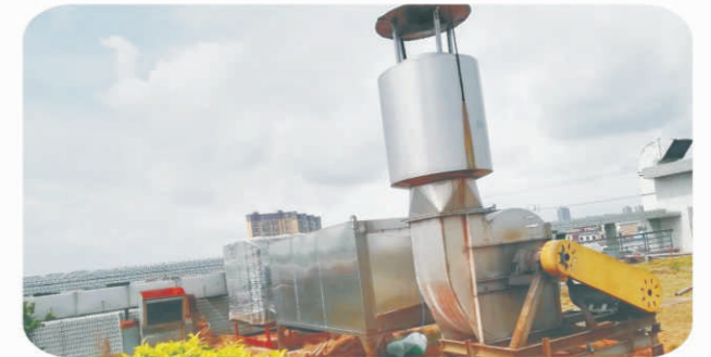
威保科技有机废气治理工程施工中
