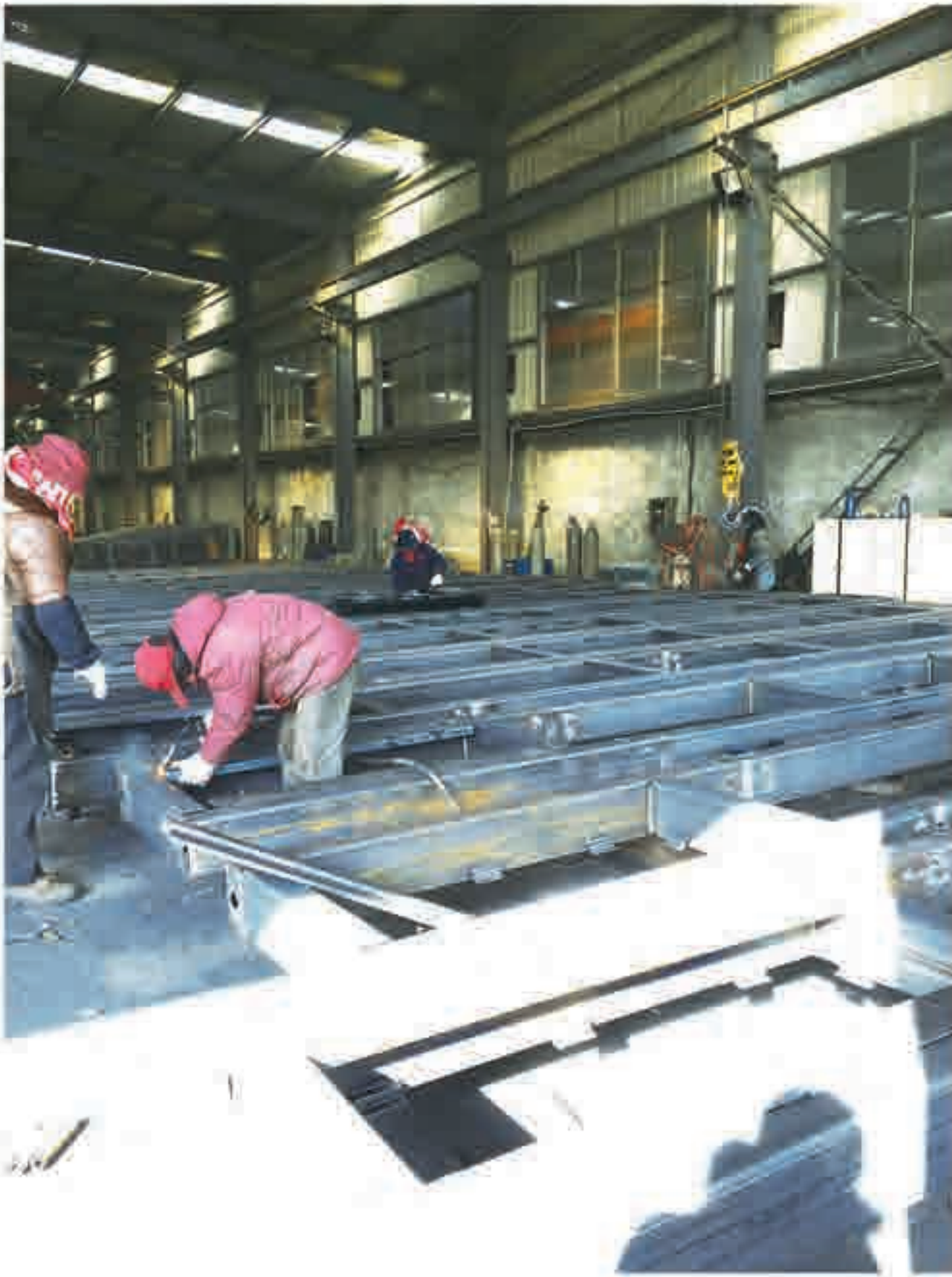
杆件焊接 打磨
