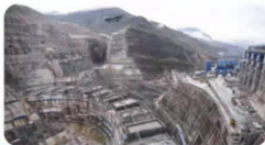
大坝浇筑现场
