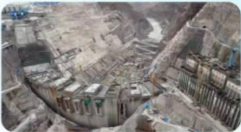
大坝建设现状
