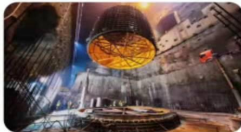
电站进水塔施工现场
