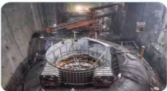
地下厂房施工
