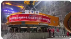
百万机组安装现场
