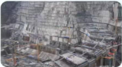
坝肩边坡开挖
