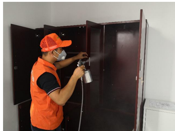
15 专项治理: 所有家具内外表面3种产品专项治理, 每道工艺确保时间间隔, 裸露板进行深层治理。
