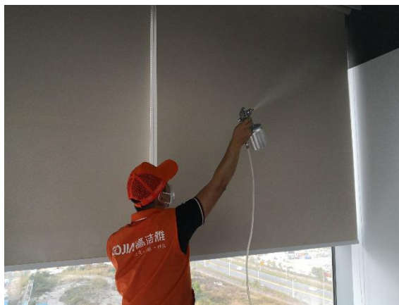
16 专项治理: 墙壁、天花、窗帘, 光触媒全面专项治理, 形成纳米涂层既分解污染又可分解游离在空间的甲醛, 形成保护网。
