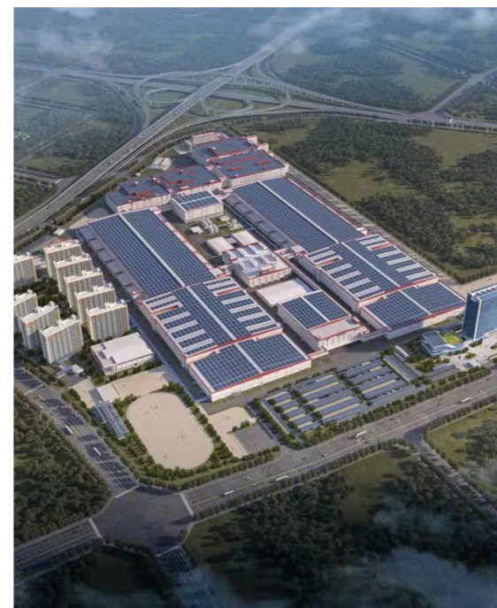
► 厦门宁德时代新能源电池产业基地
