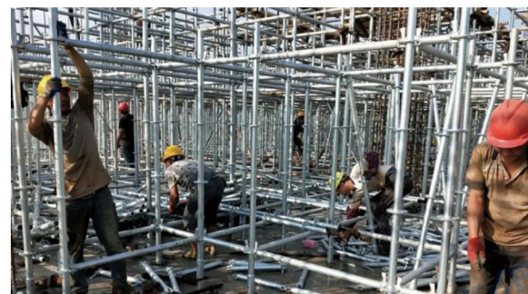
传统PC叠合板施工临时支撑
