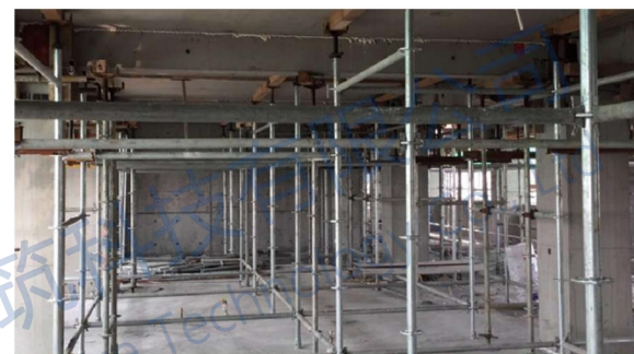
钢筋桁架免拆楼承板施工临时支撑
