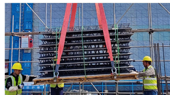
钢筋桁架免拆楼承板吊装
