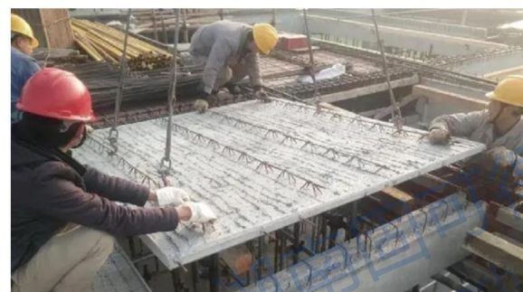
PC叠合板铺板
