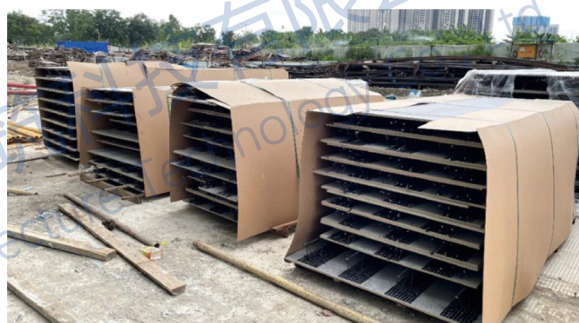
钢筋桁架免拆楼承板卸货及堆货
