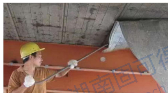
铁皮桁架楼承板
