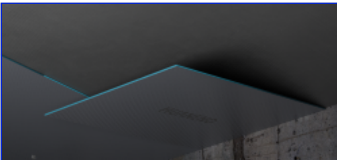
顶面铺贴施工工法
