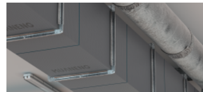
通风管道施工方法
