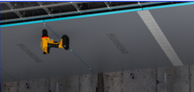
轻钢龙骨吊顶施工工法
