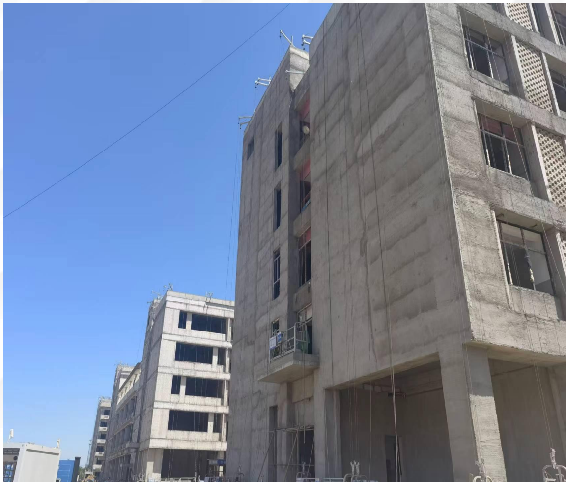
墙体板表面分层喷抹砂浆
