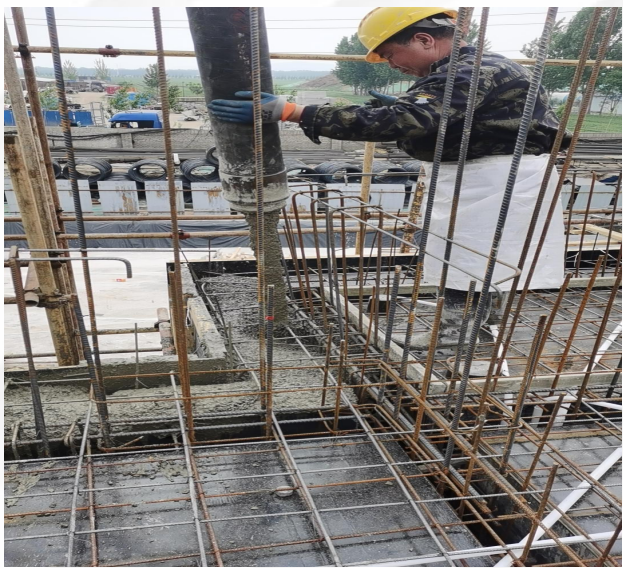
混凝土浇筑
