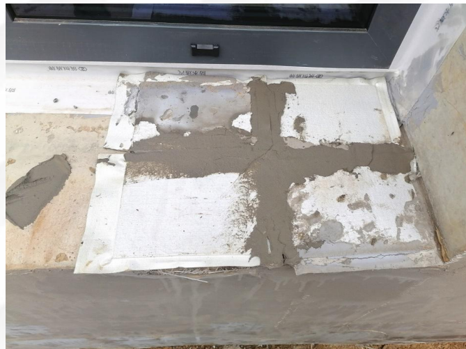
窗台STP真空绝热板安装
