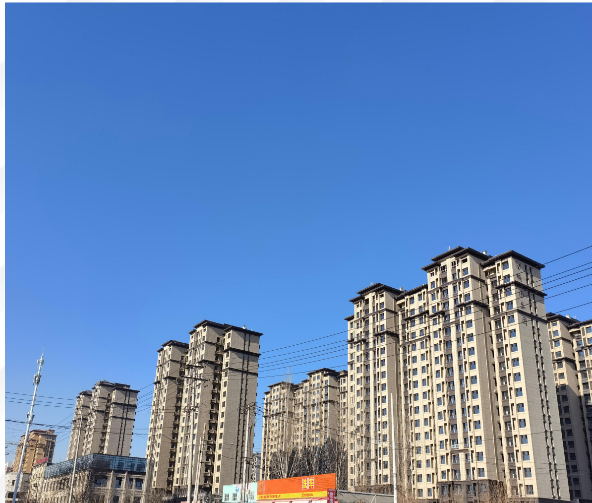
中南置地--固安中南.熙悦项目
