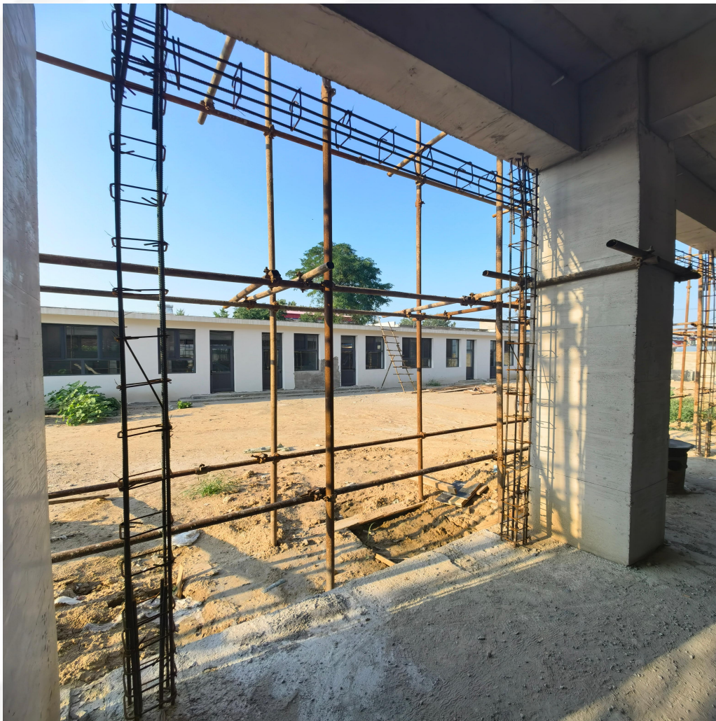
安装型钢或钢筋混凝土构造柱
