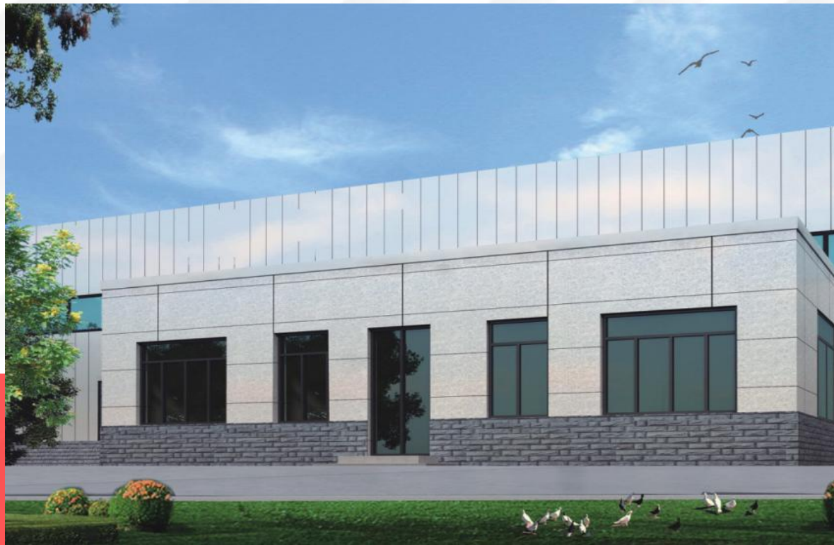
廊坊轩越建材有限公司--被动房示范区
