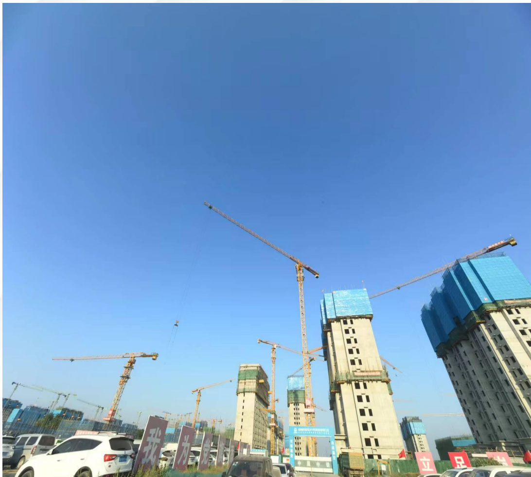
临空集团--廊坊临空家园项目B/C地块
