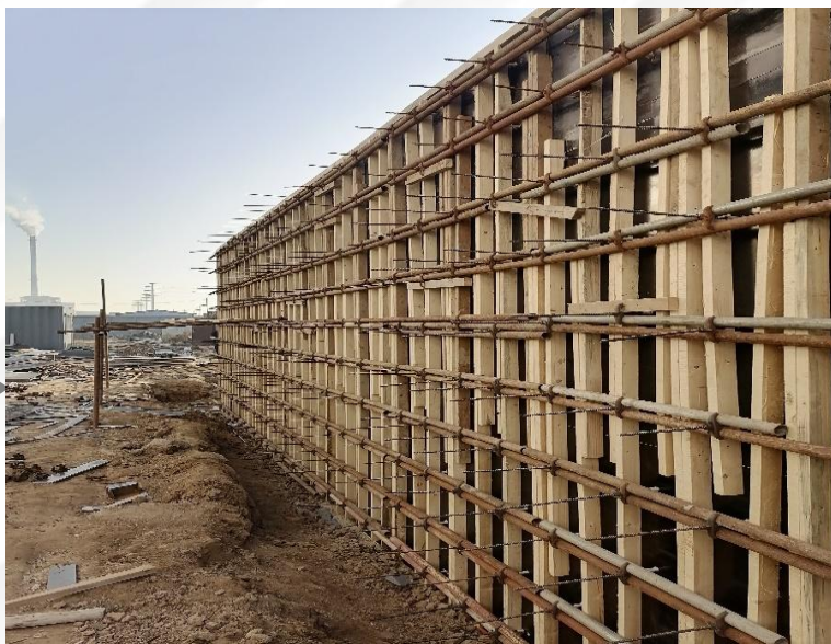
内外模板安装完成加固
