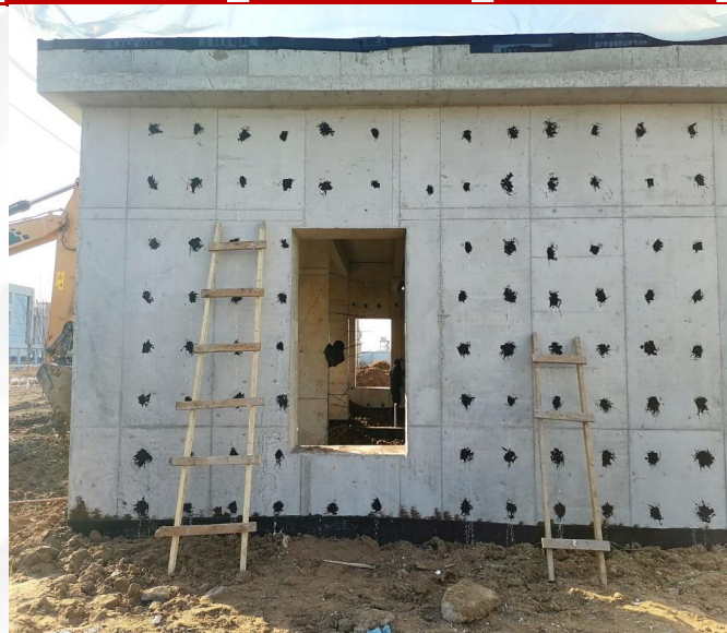
螺栓孔填堵
