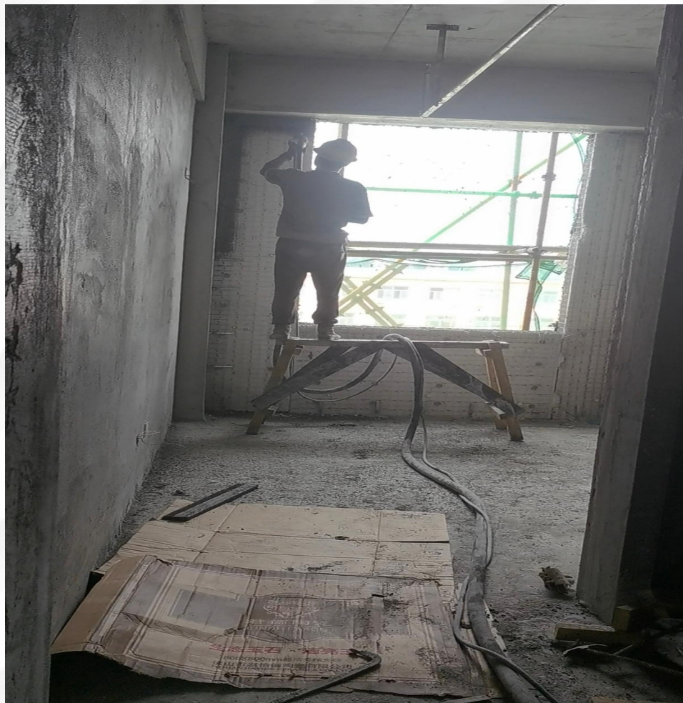
墙体板表面分层喷抹砂浆
