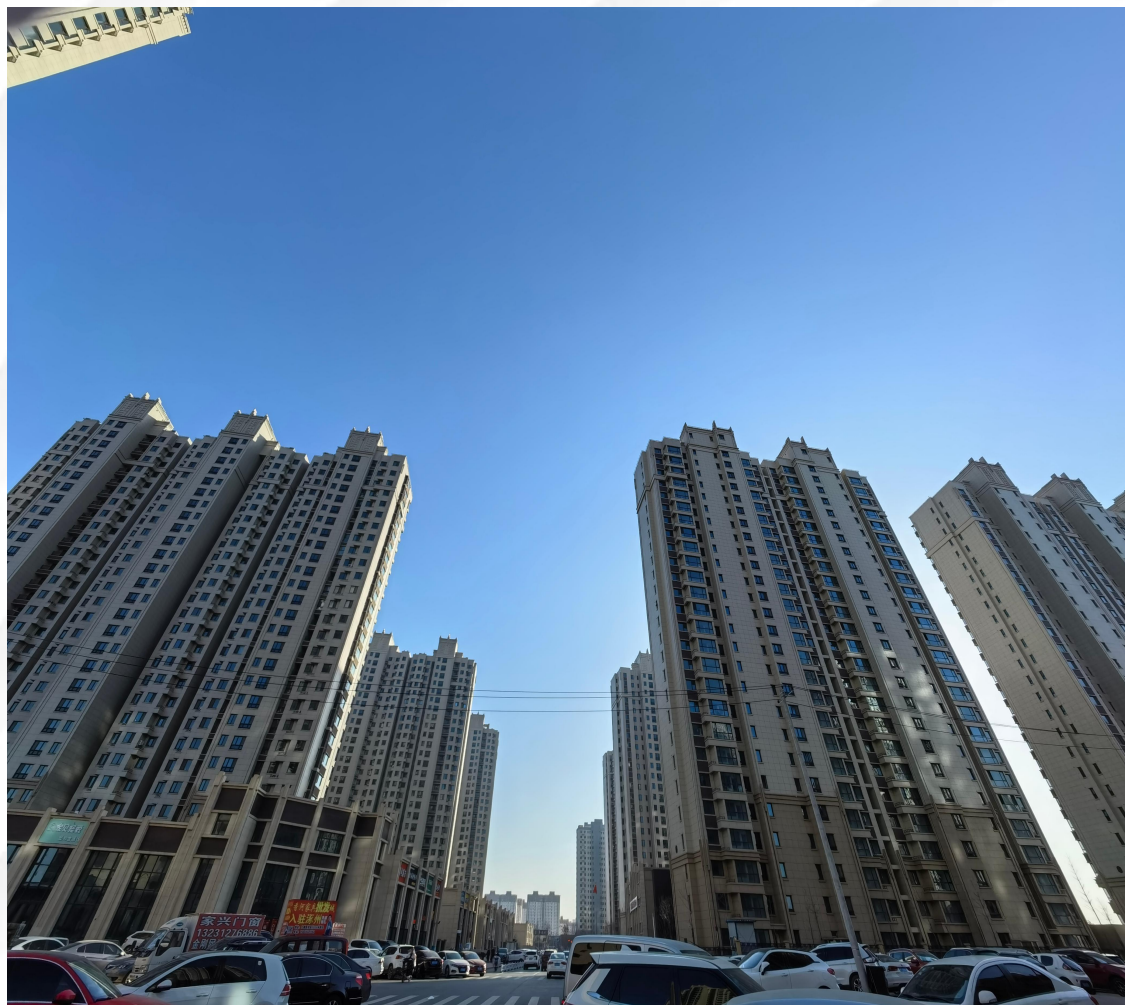
荣盛地产--固安白沟河河道治理安置项目
